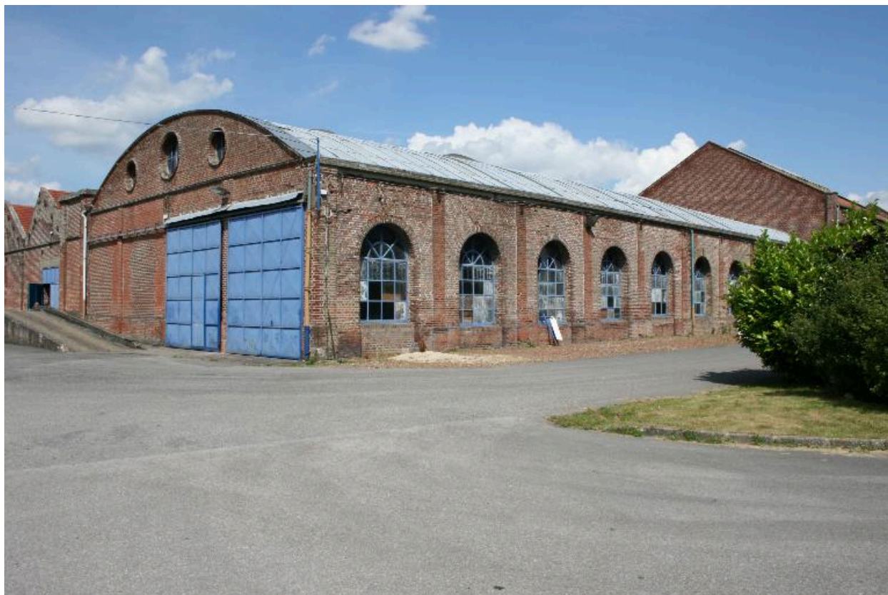
Vue d'ensemble extérieure de l'atelier de pliage.
