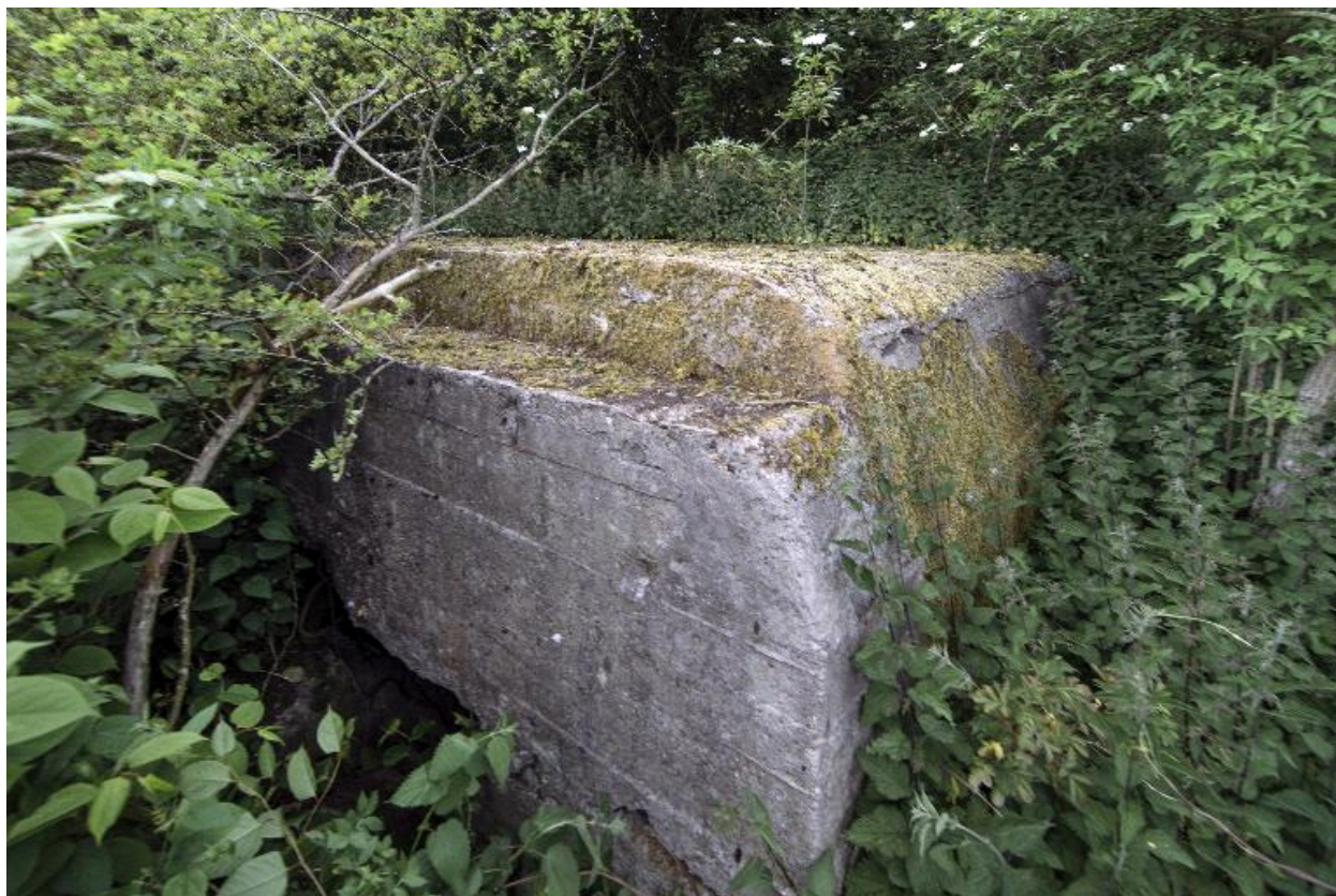
Seule partie visible de l'édifice. Le couverture, vers le nord-ouest
