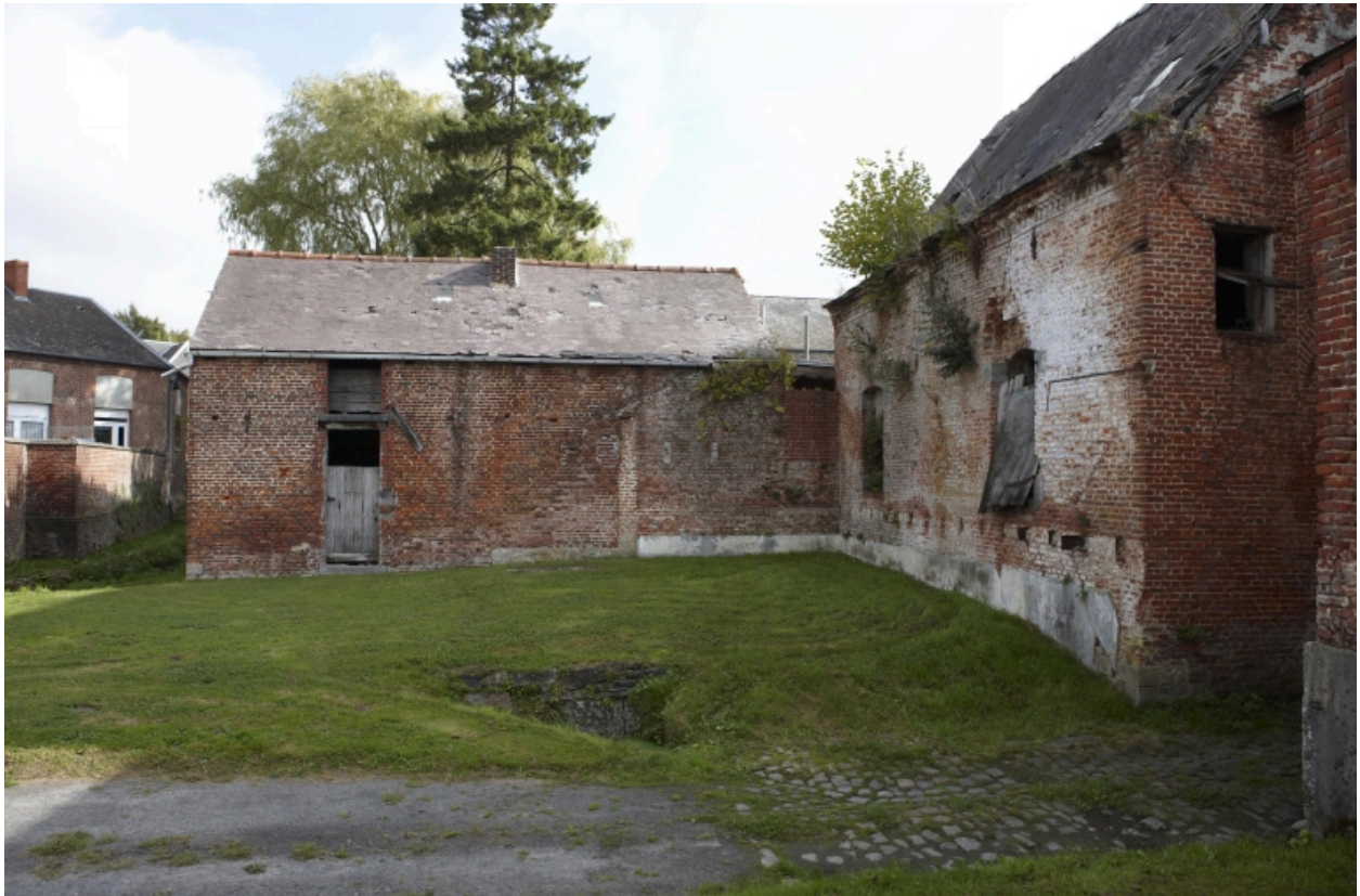
Détail de l'élévation sur rue : l'ancienne salle des cuves et l'étable.
