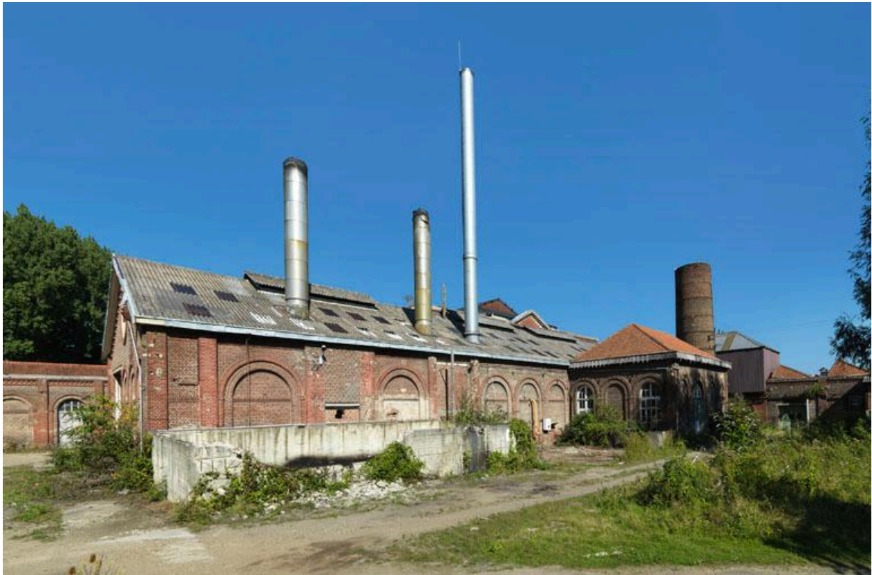
Vue d'ensemble sud de l'ancienne blanchisserie et teinturerie.
