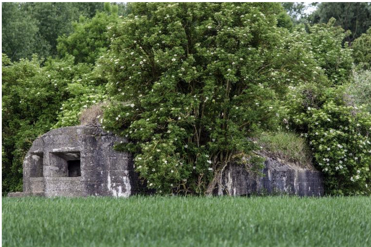
Vue générale vers le sud-ouest
