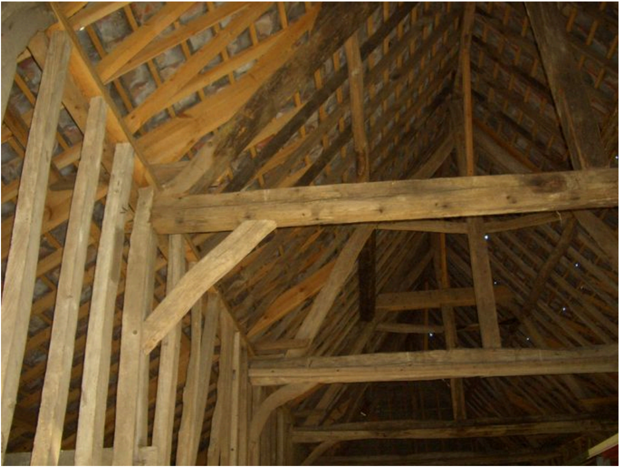
Vue partielle de sa charpente.
