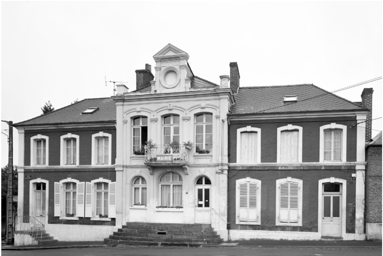
Vue d'ensemble de la façade.
