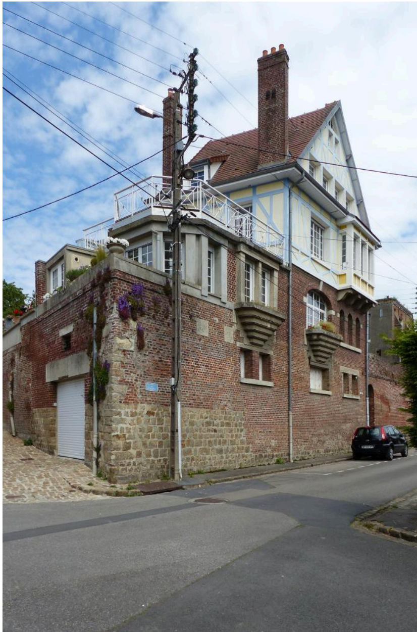
Demeure, 16 rue Fournier, reconstruite vers 1930. Vue depuis la rue du Collège.
