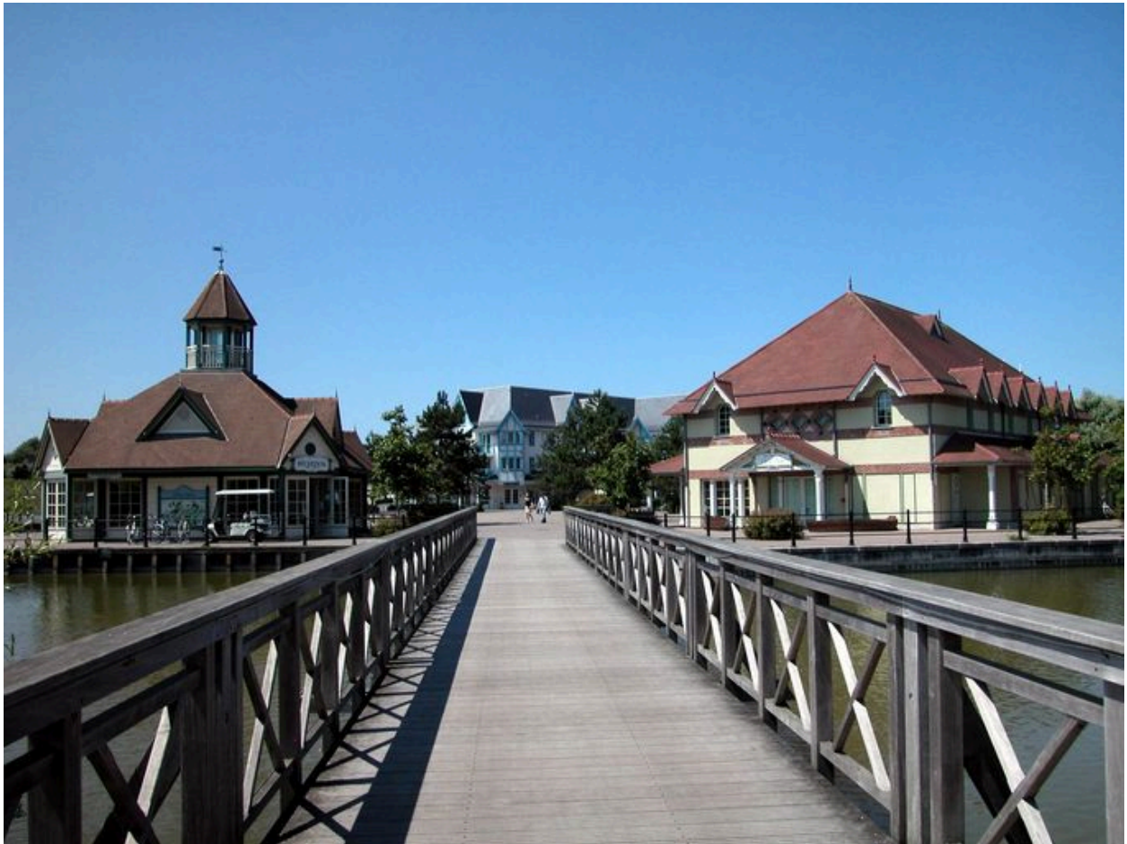
Belle-Dune, vue des équipements d'accueil, de restauration et d'hébergements collectifs.
