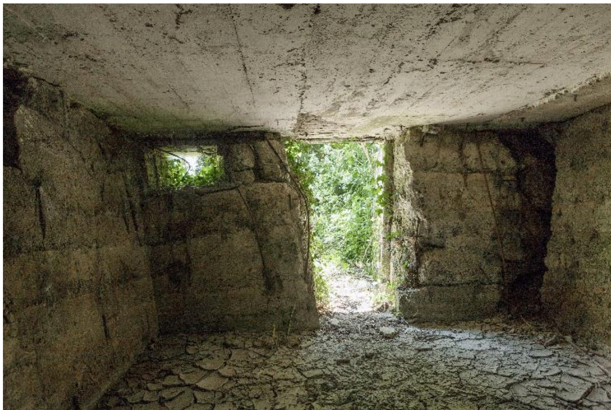
Vue intérieure vers la sortie sud
