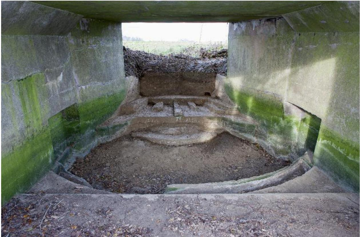
Vue intérieure vers le sortie de la chambre de tir avec, au sol, la plate-forme du canon.
