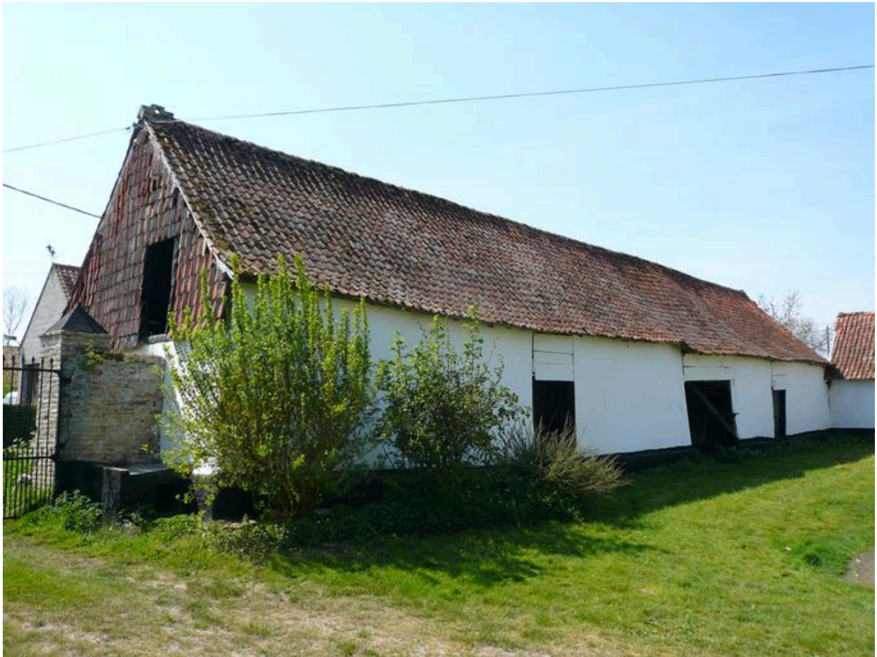
Vue de la grange située à l'ouest de la cour, le long de la route.
