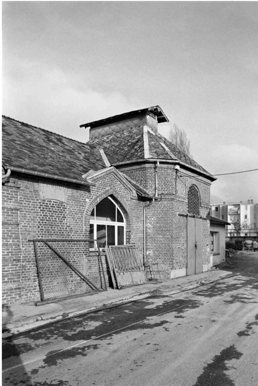
Vue d'un bâtiment de l'abattoir élevé par Gustave-Eugène Dupont entre 1898 et 1901.
