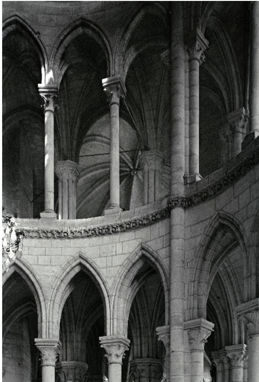
Détail de l'élévation intérieure du bras sud du transept.
