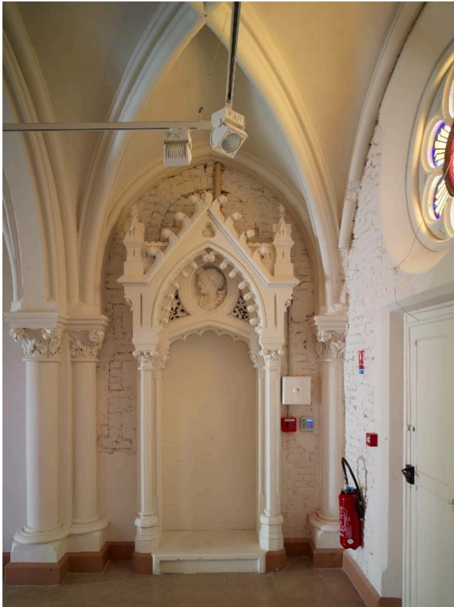
Vue d'un ancien confessionnal.
