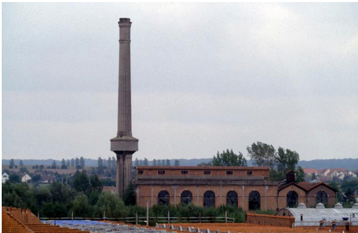
La chaufferie et la cheminée en 1993.
