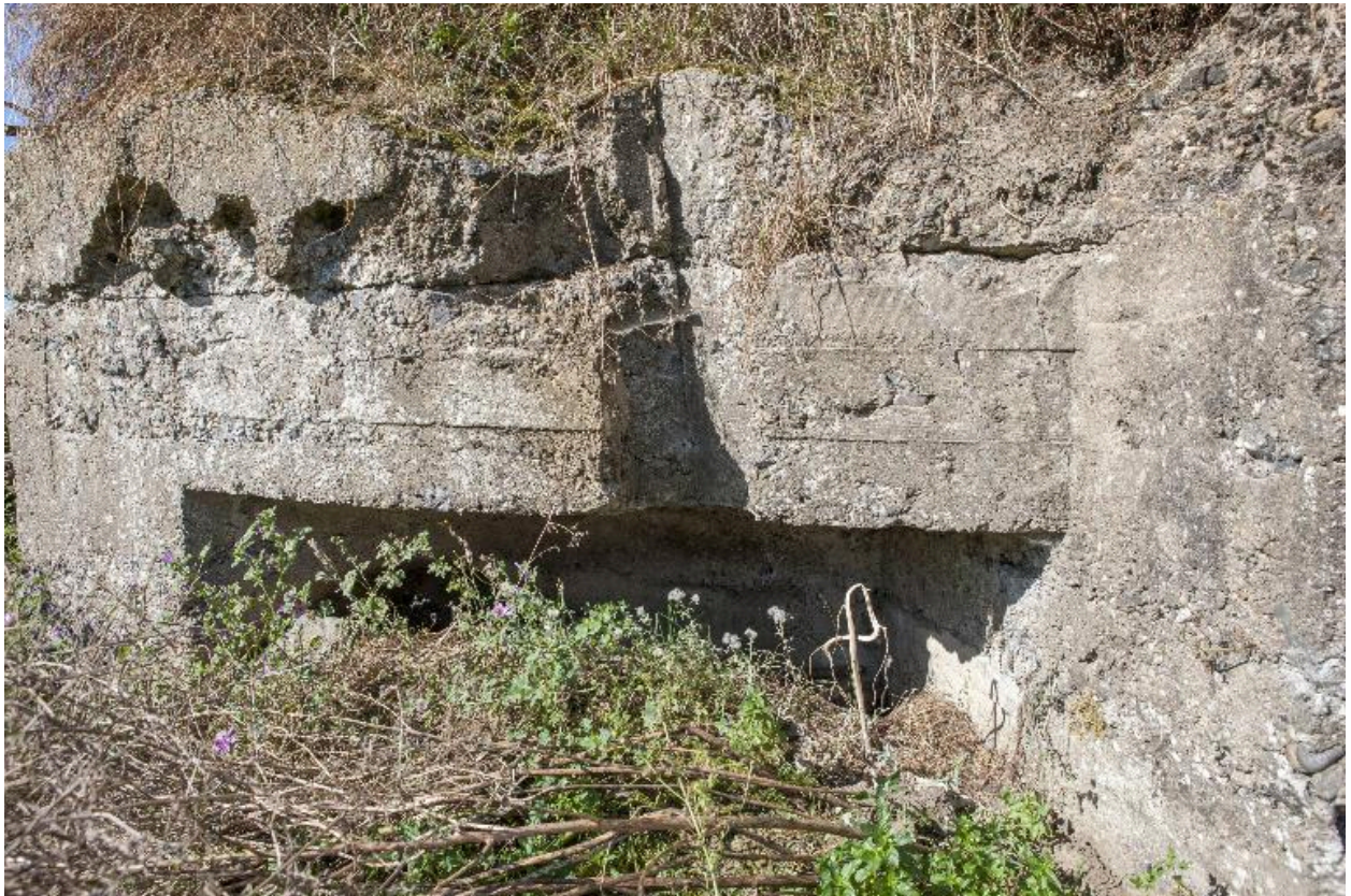
Elévation est, détail
