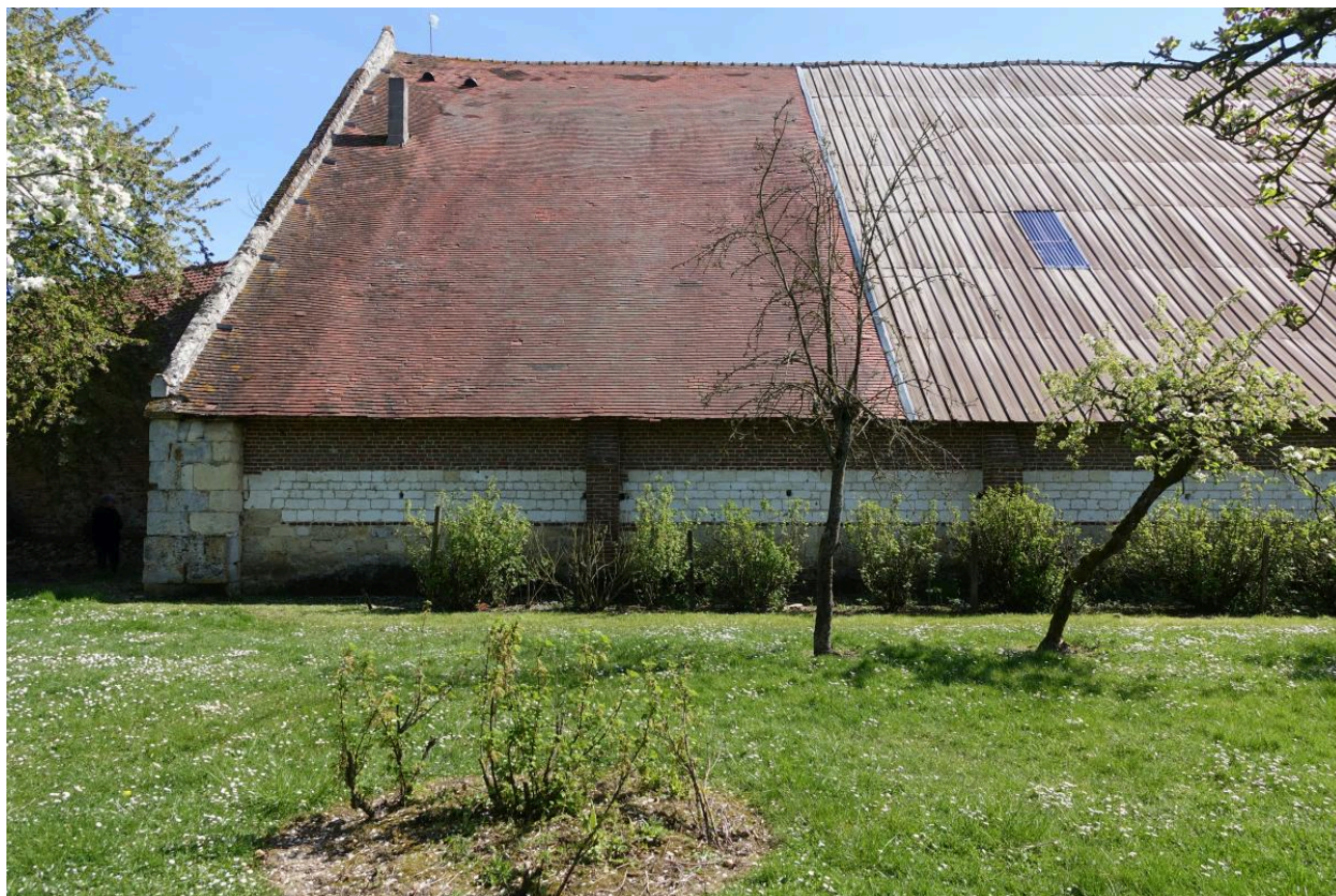
Vue générale de la partie nord-est de la grange.
