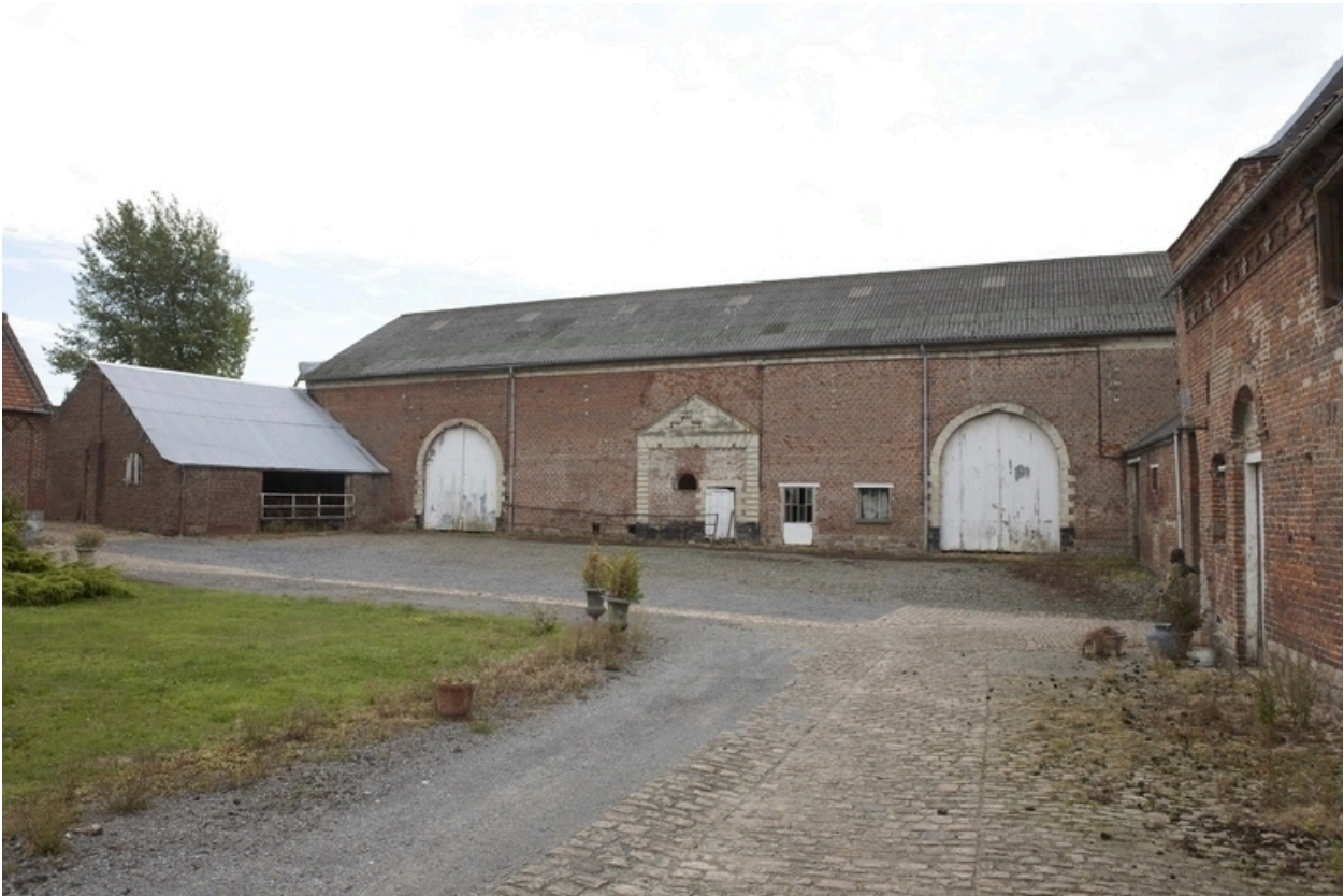
Vue de la grange-étable située au sud.
