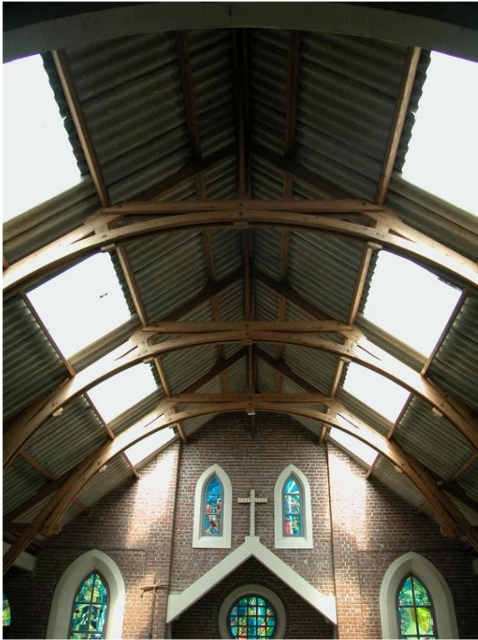
Détail de la charpente.
