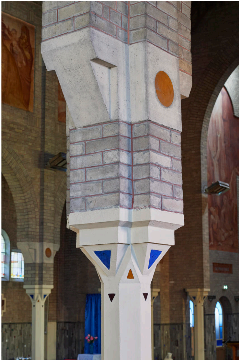
Les piliers en béton armé de la nef.
