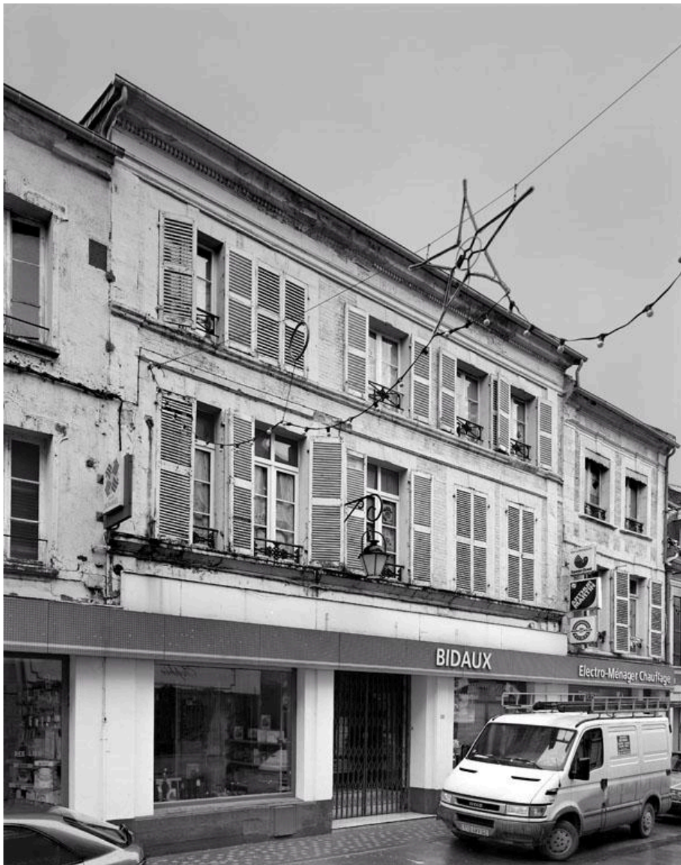
Vue de la façade sur rue.
