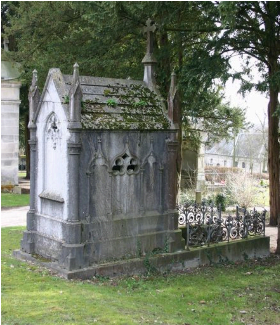
Vue générale (face postérieure).
