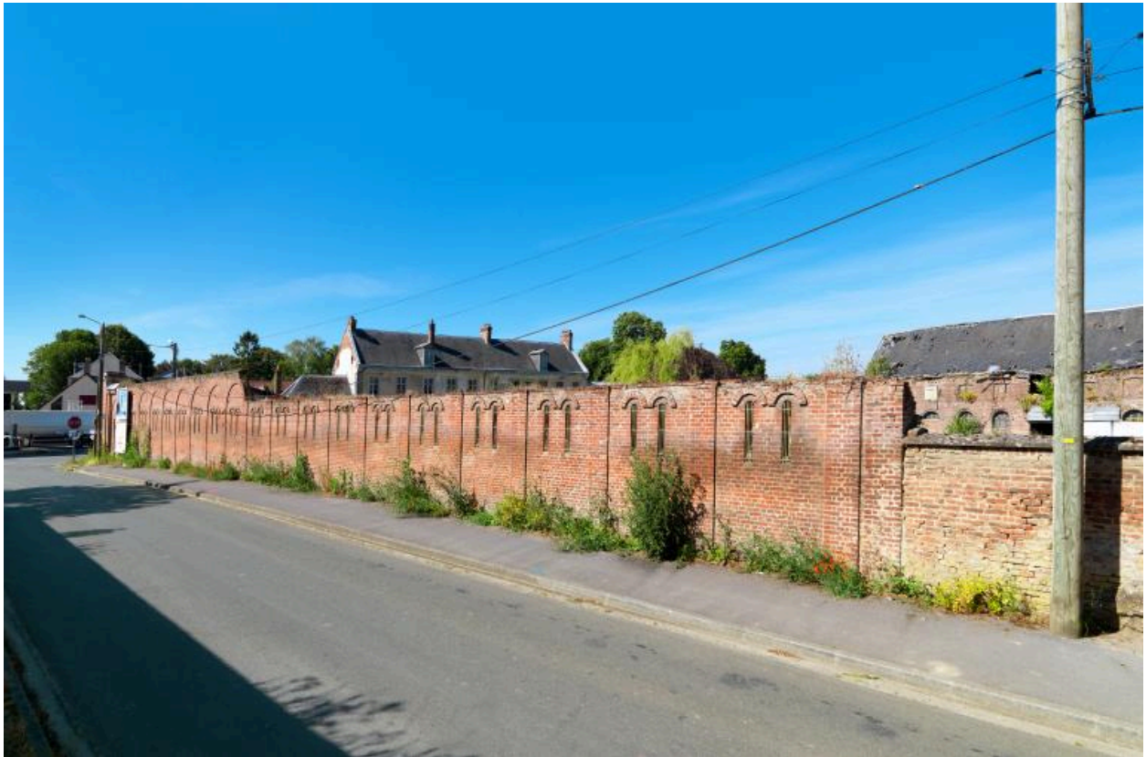
Vue depuis la rue d'Aubigny. Mur des anciennes écuries.
