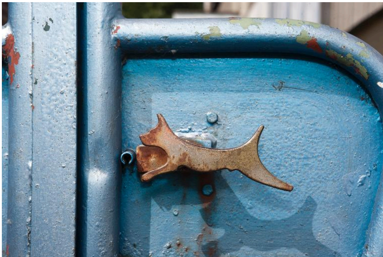
Portail d'entrée dans la cour : détail.
