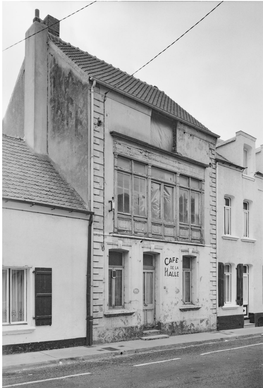
Vue générale du commerce depuis la rue.
