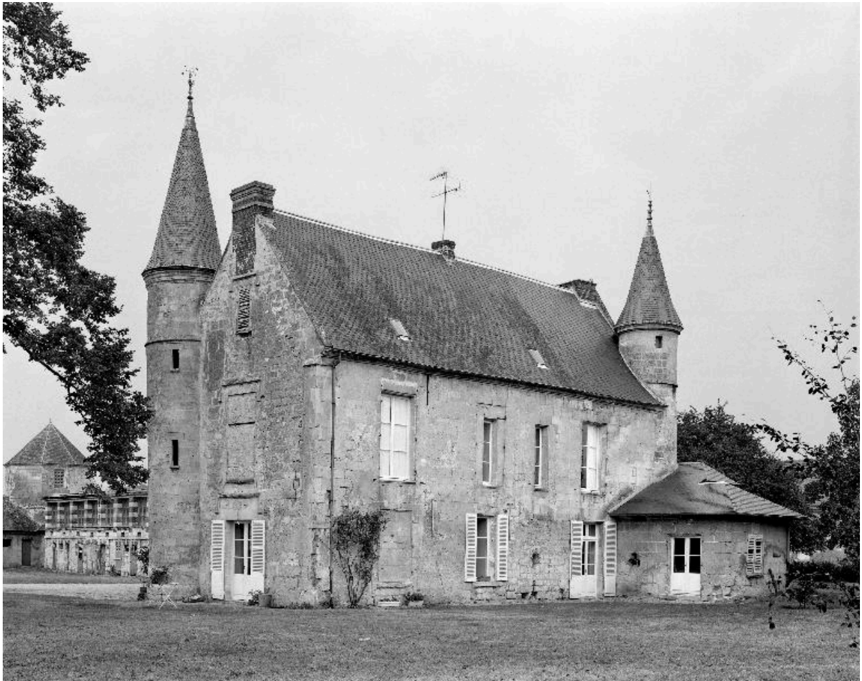
Vue du logis depuis l'est.
