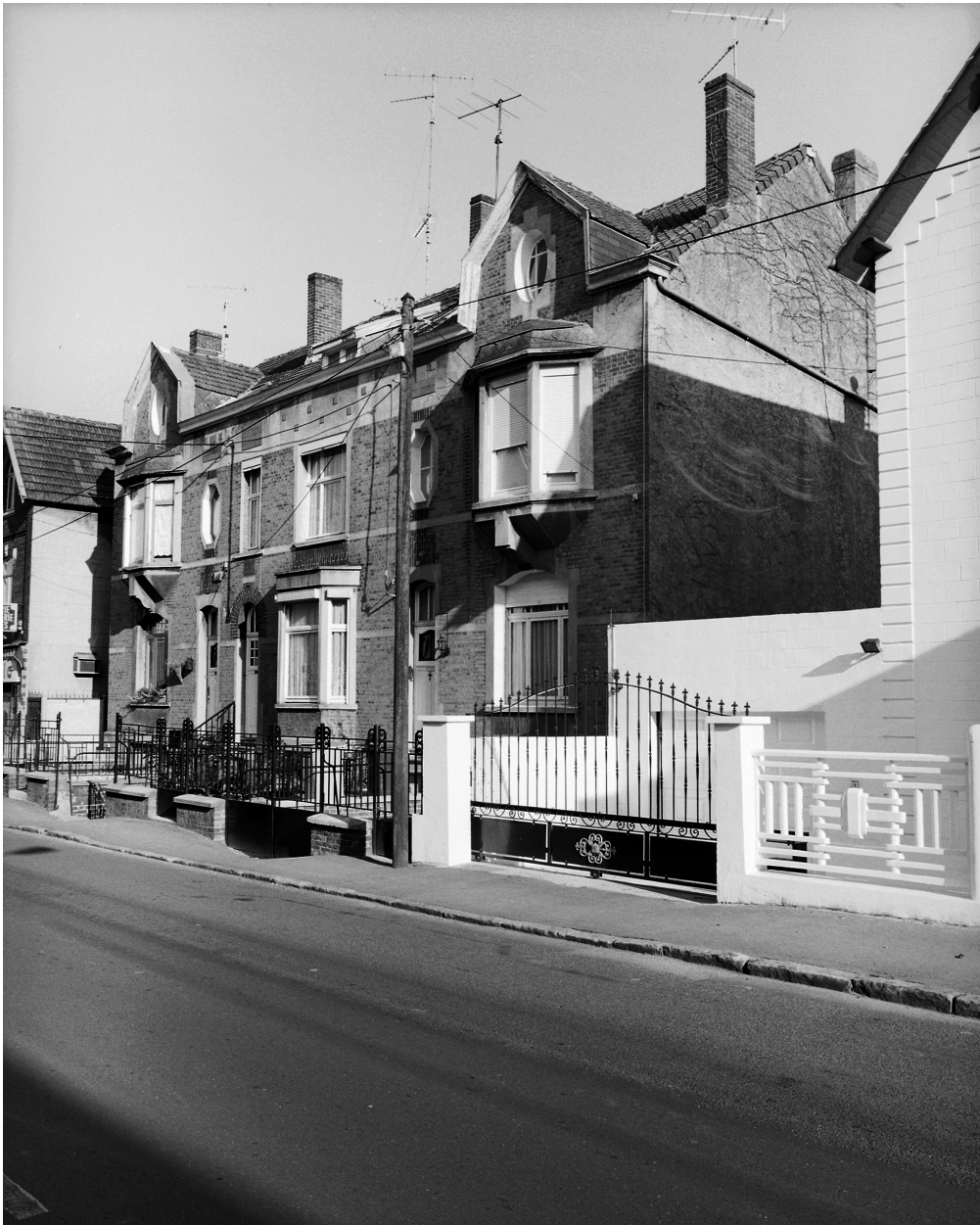
Vue générale de trois quarts prise depuis le nord.
