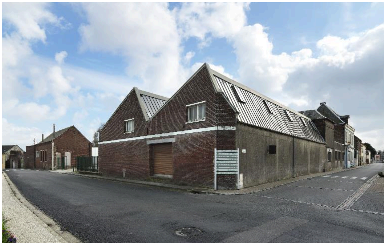
Ancienne usine Haudiquer, 14 rue de l'Eglise.
