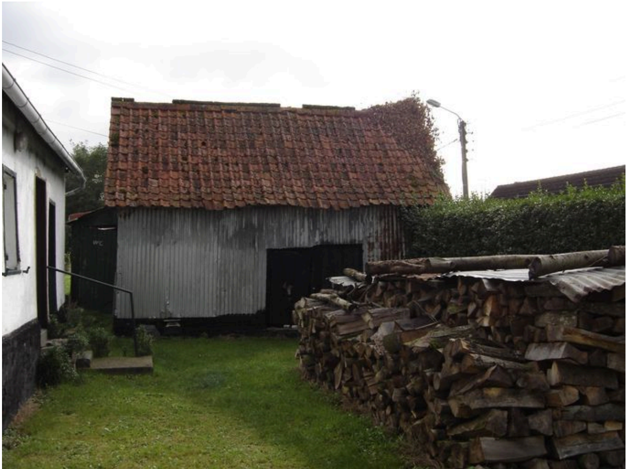
Vue de la grange.
