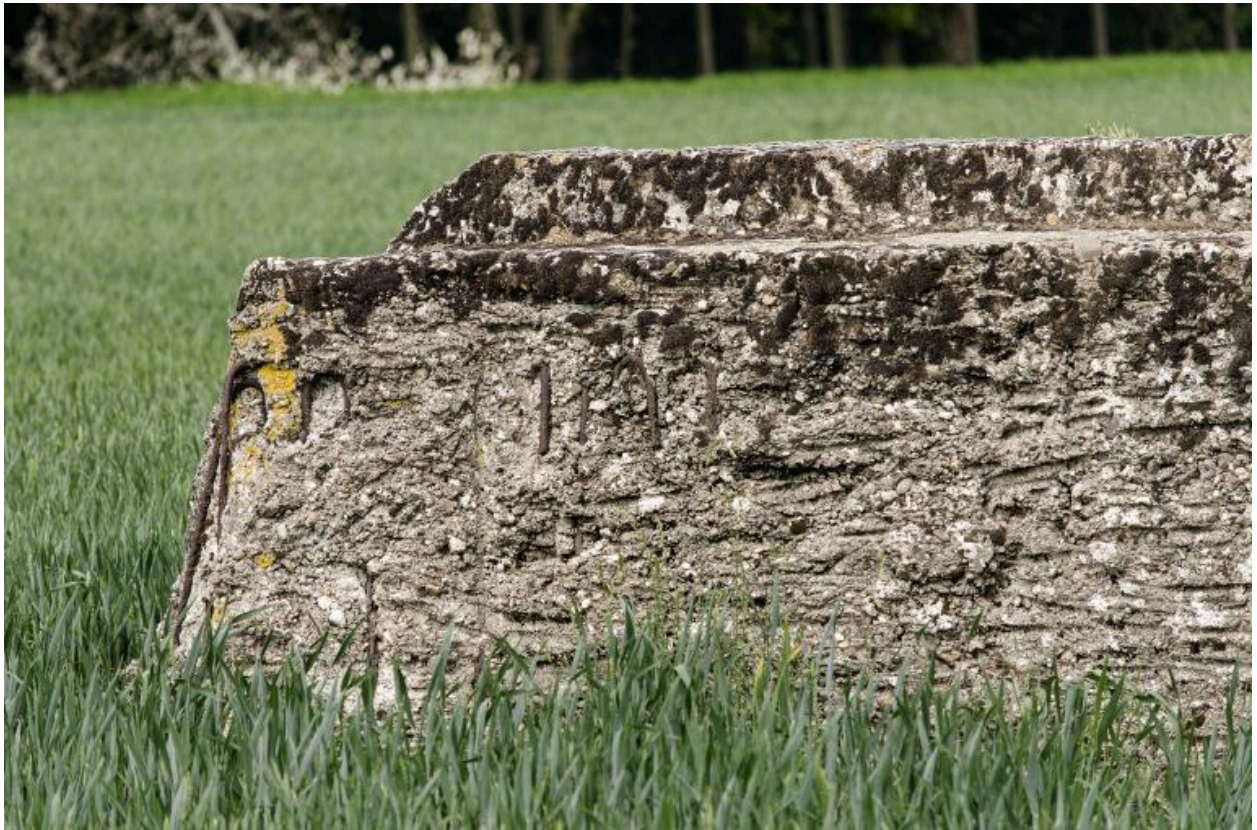
Détail du ferrailage sur l'élévation sud-est.
