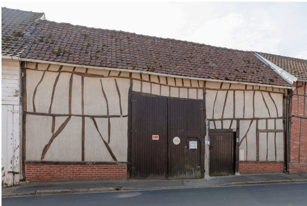
Grange sur rue, n°34 de la rue Roland-Mariage, vue prise depuis le nord.
