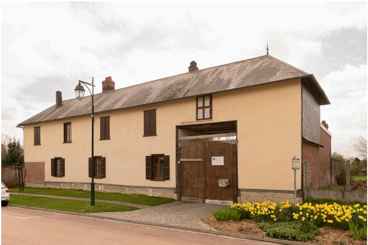
Logis sur rue avec entrée charretière, n°46 de la Neuve-Rue, vue prise depuis le nord.
