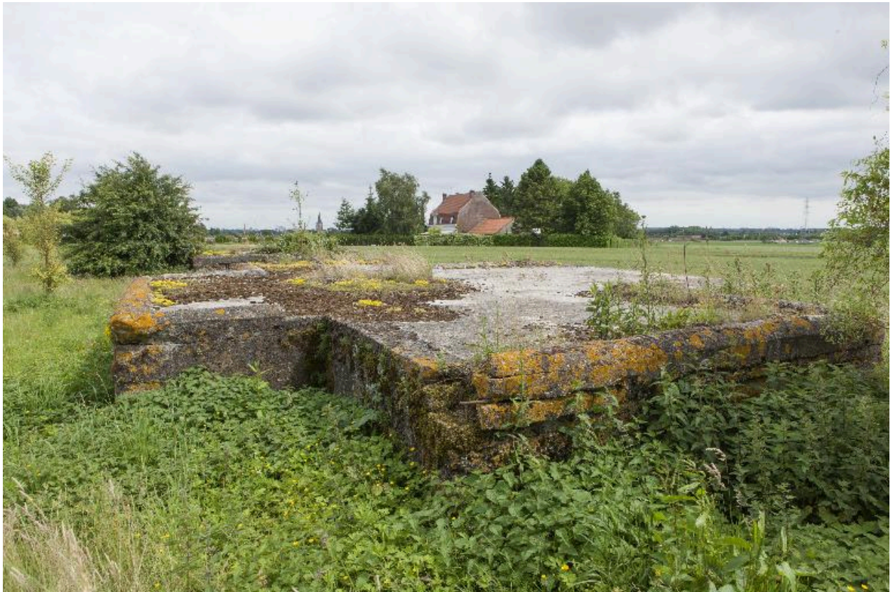
Vue de trois-quarts, vers le sud-est, de la casemate ouest
