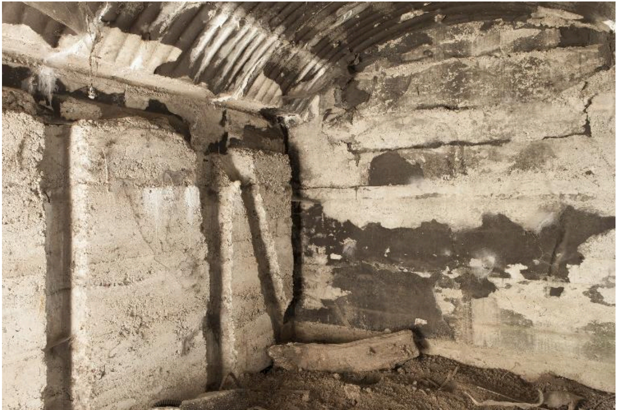
Bâtiment 1, vue intérieure
