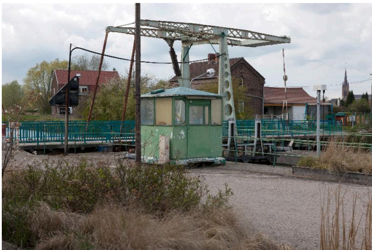
Vue générale de l'écluse de Warlaing.
