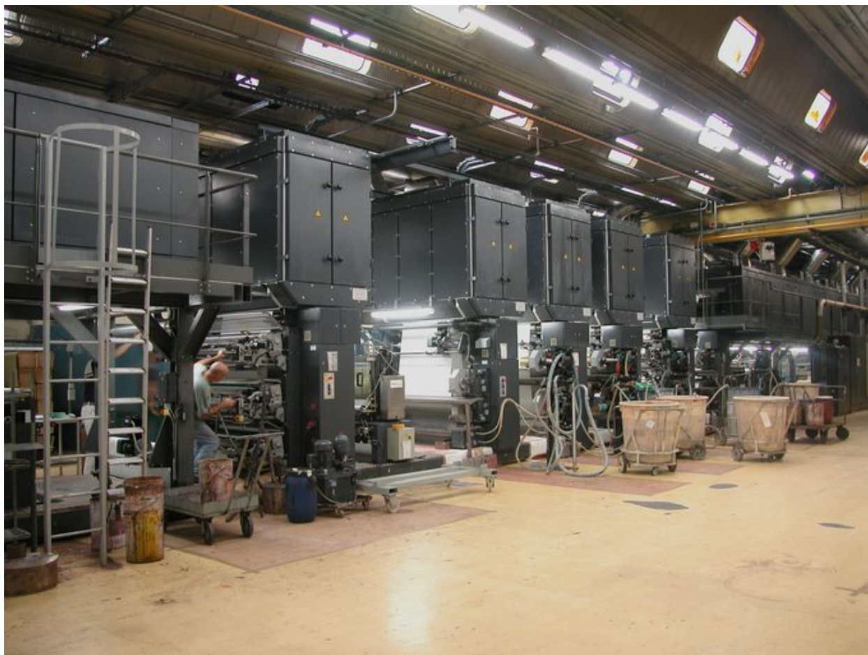
Vue d'ensemble d'une des chaînes de fabrication.
