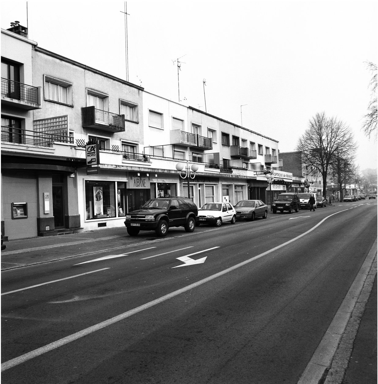
Vue générale de l'îlot M, l'élévation antérieure, donnant sur l'avenue de France.
