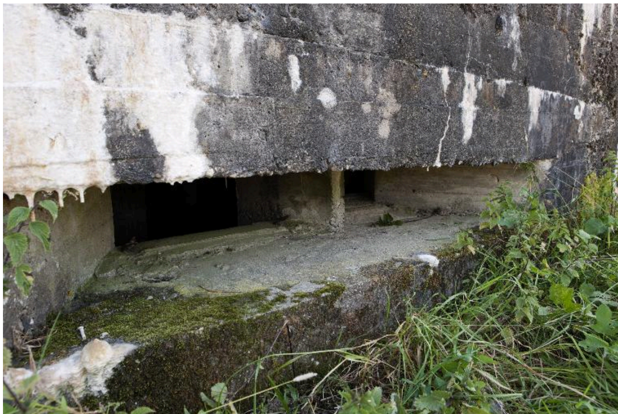
Elévation nord : Embrasures de tir et de surveillance
