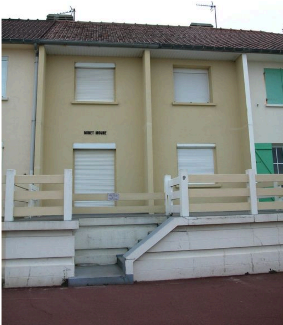
Détail d'une unité, façade antérieure.
