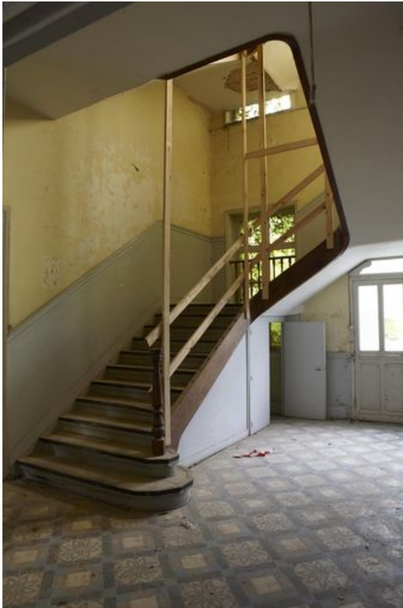
L'escalier de distribution.
