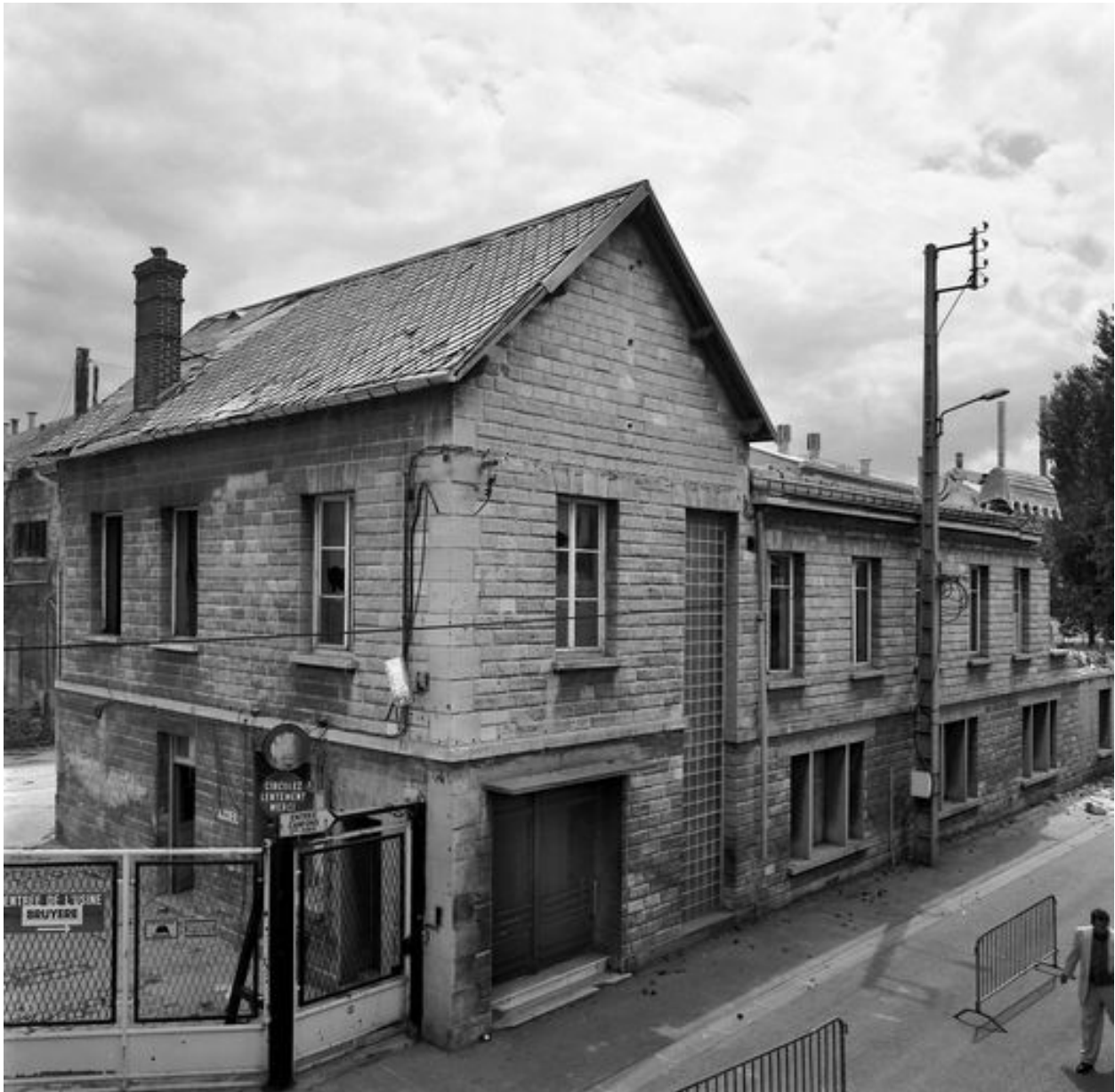
Les bureaux depuis le pont Y, en 1999.
