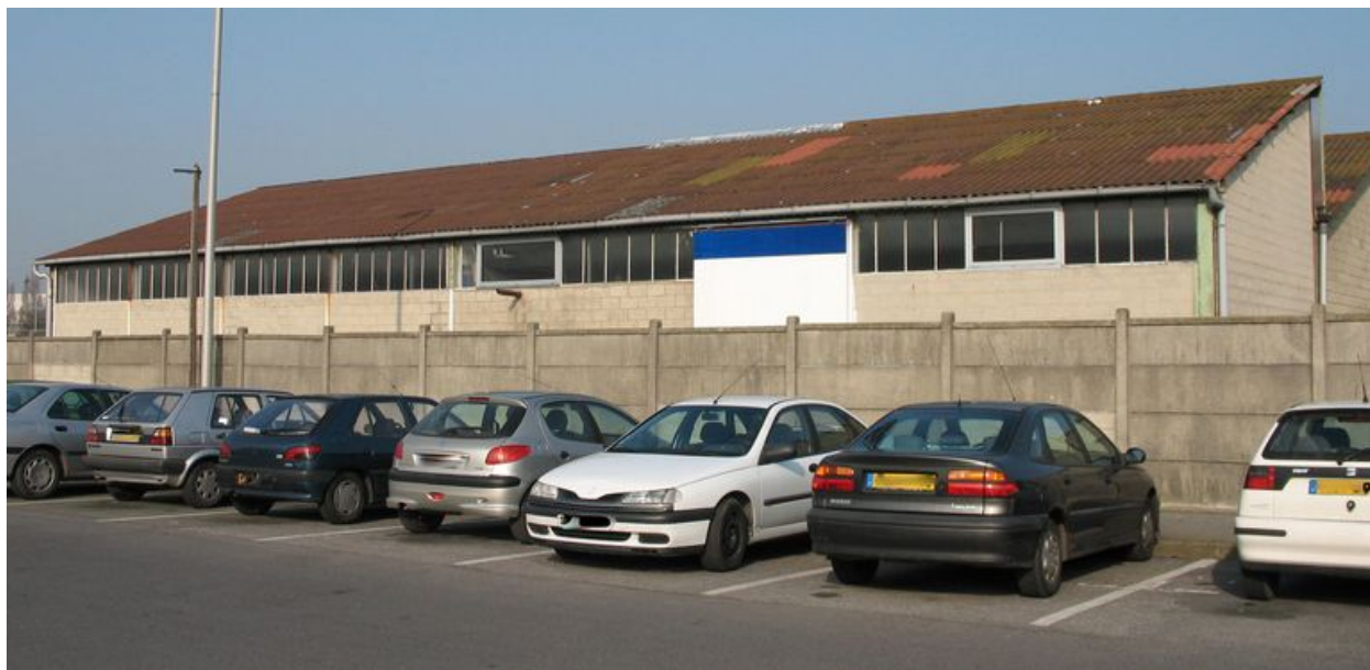
Mur pignon sud des ateliers de fabrication.
