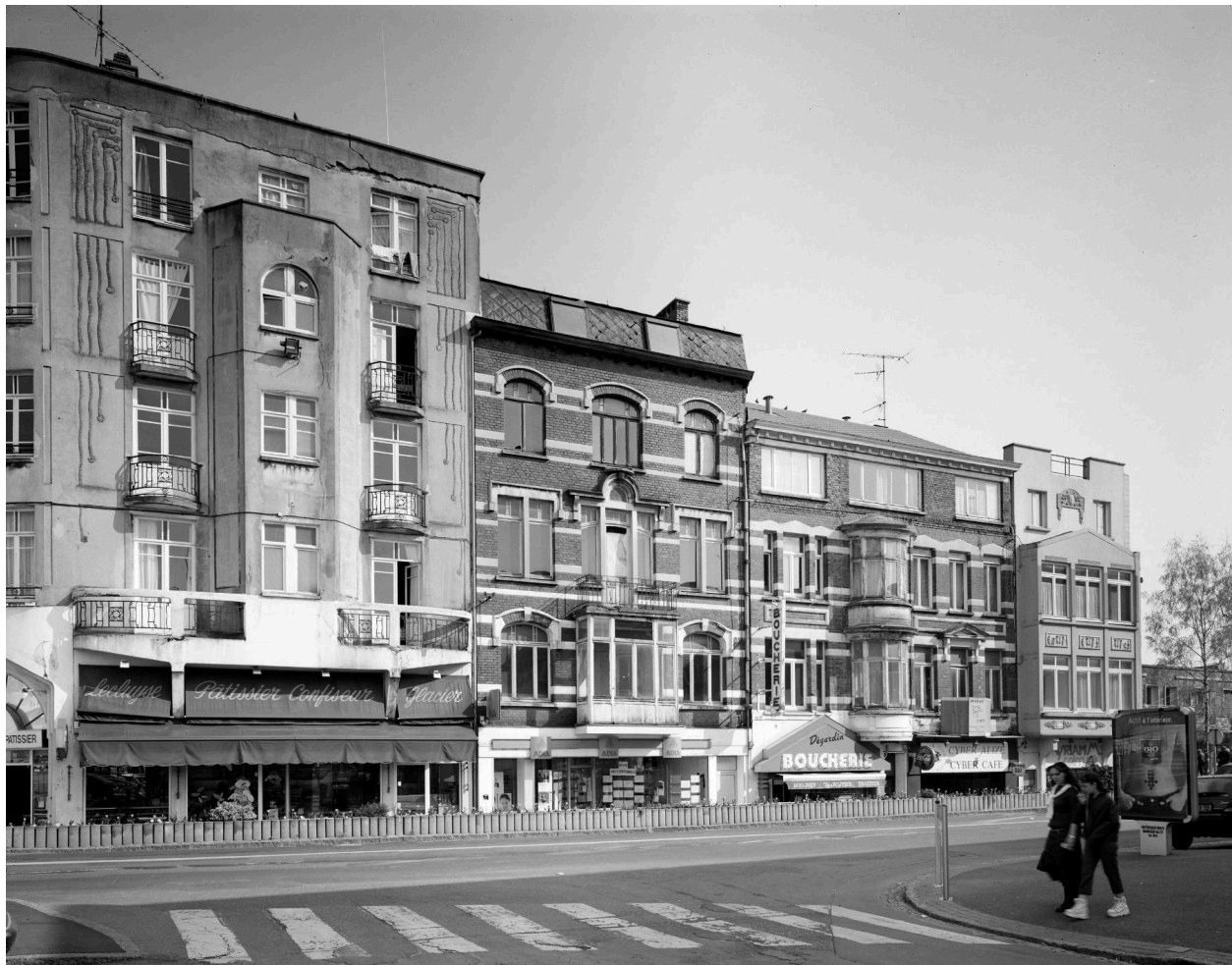
Vue générale d'un alignement de maisons construites pendant l'entre-deux-guerres, situées avenue de France (détruit).
