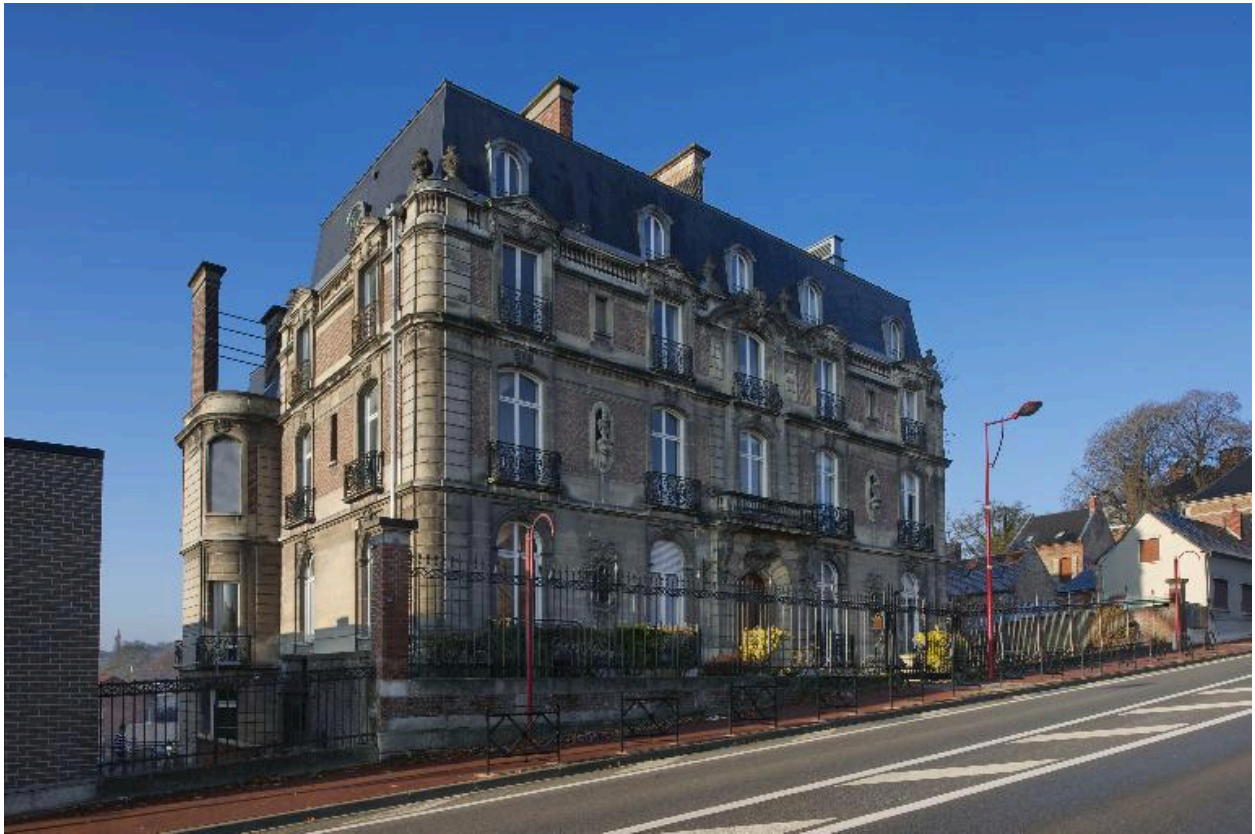
Façade sur rue, vue de trois-quarts.
