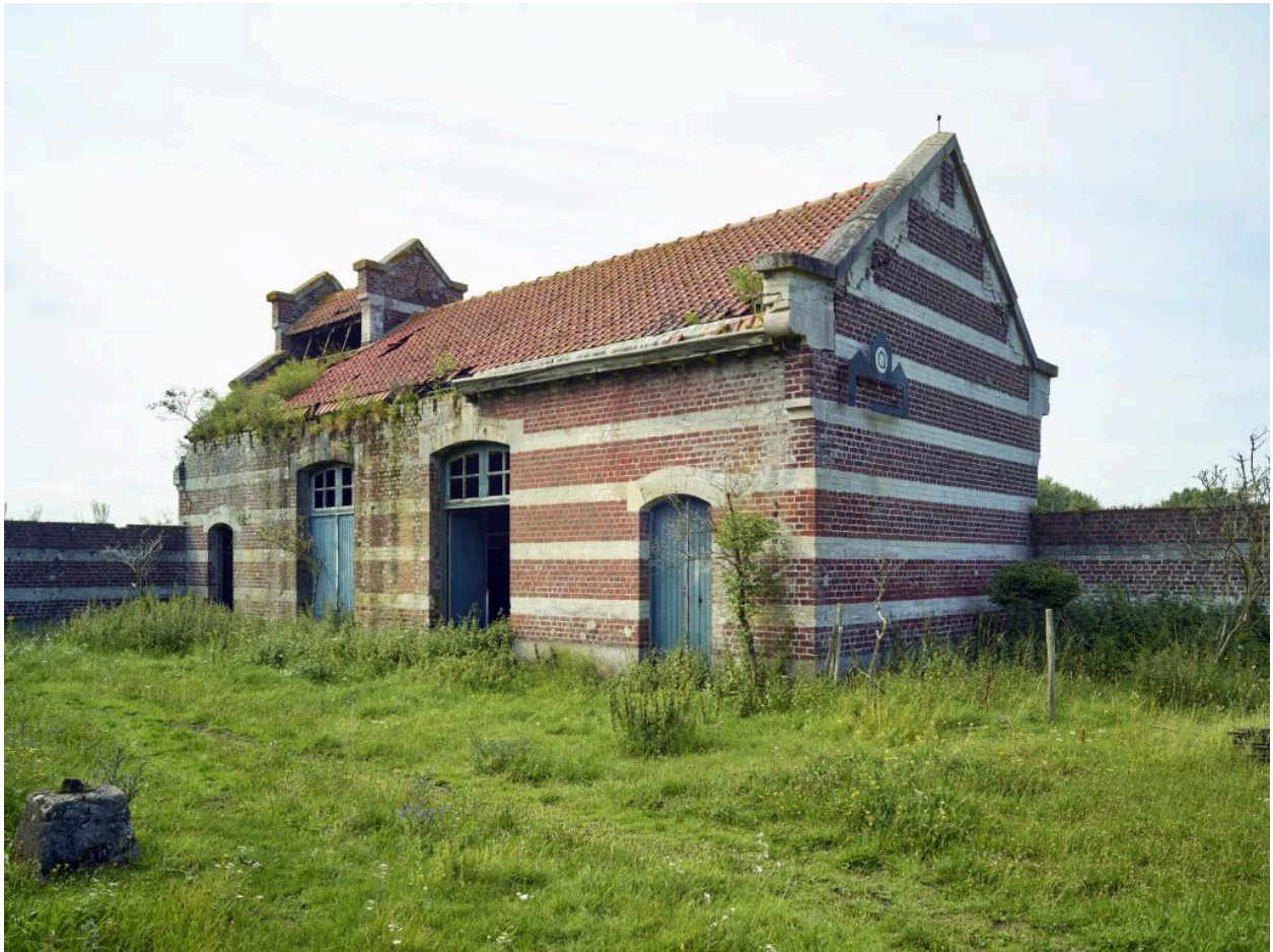
Abattoir, vue d'ensemble nord-est.
