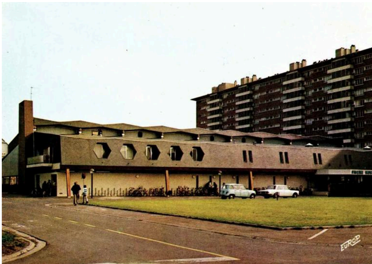
La piscine de Ronchin (réalisation du projet-type agréé n°122 de l'architecte Jean Doldourian), carte postale, vers 1975 (coll. part.).
