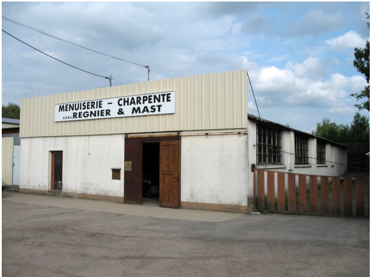
Vue générale de la menuiserie.
