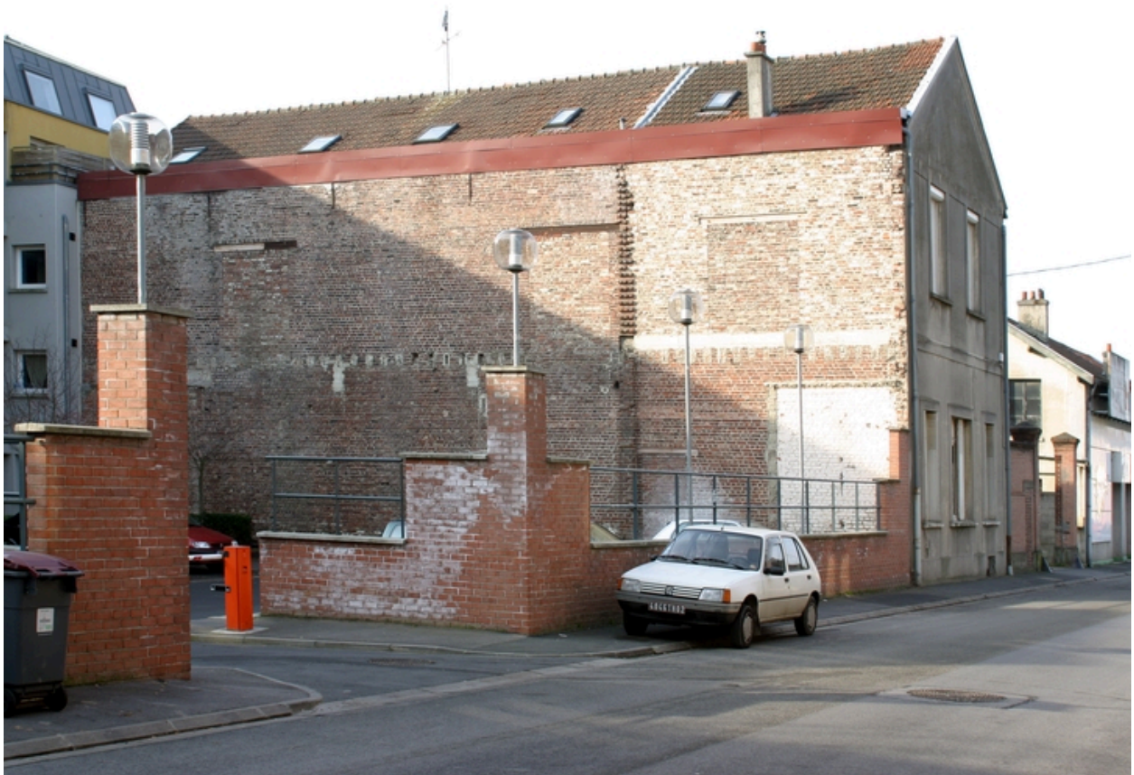
Façade postérieure d'un atelier de la rue de Vicq.
