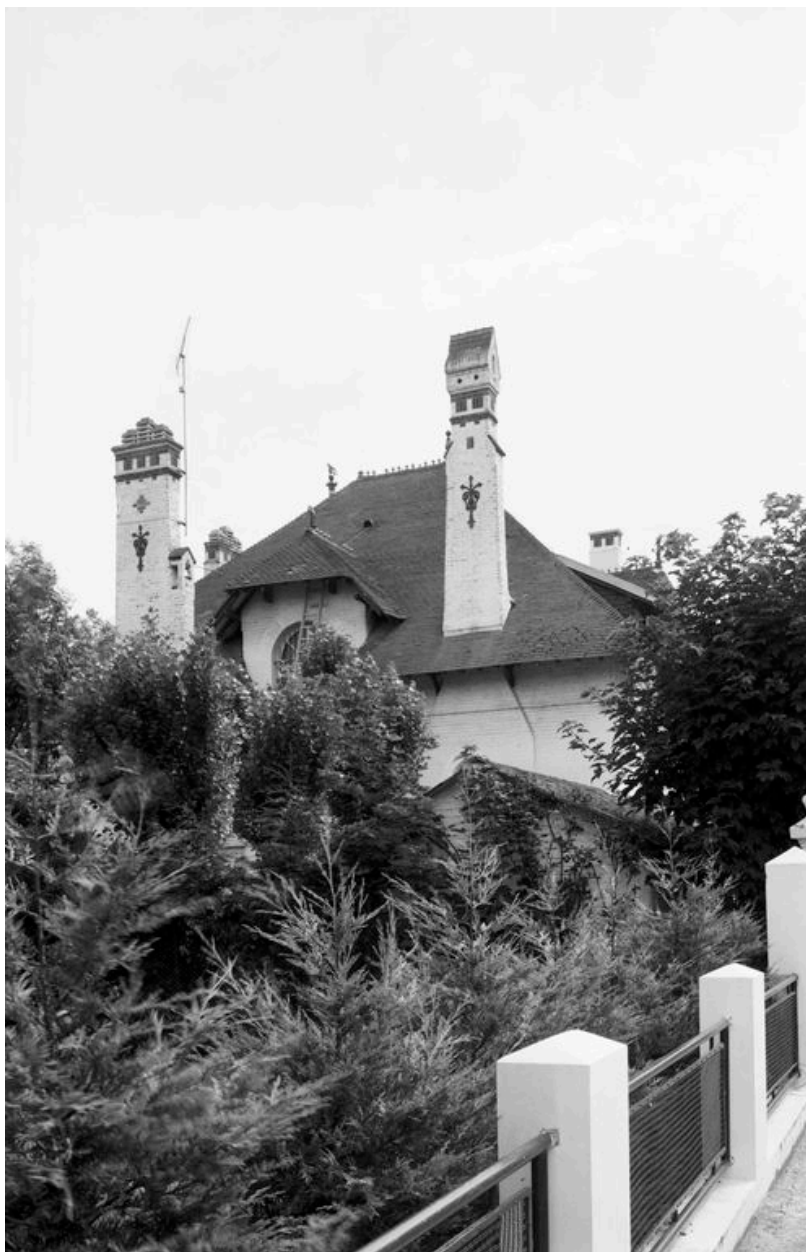
Vue générale postérieure, en 1981.
